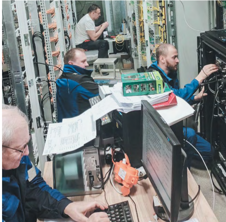
Монтаж оборудования проводят сотрудники компании «Новиком»
