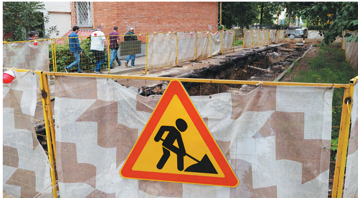
На улице Новой работы остановились, а траншея осталась
