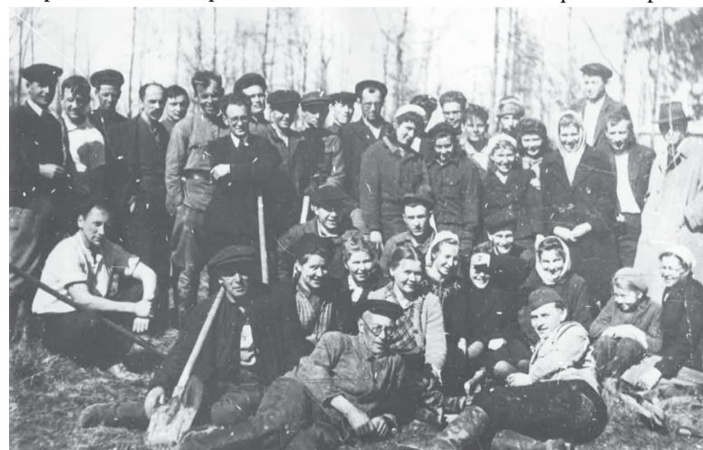
Сотрудники института на стройке первого дома по ул. Центральной
