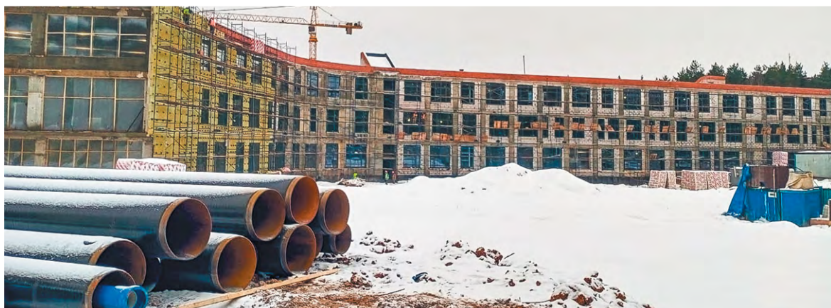
Строительство школы идёт рекордными темпами
