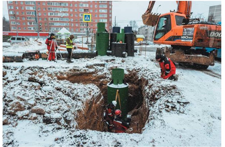
Техника вгрызается в мёрзлую землю. Идёт перекладка коммуникаций
