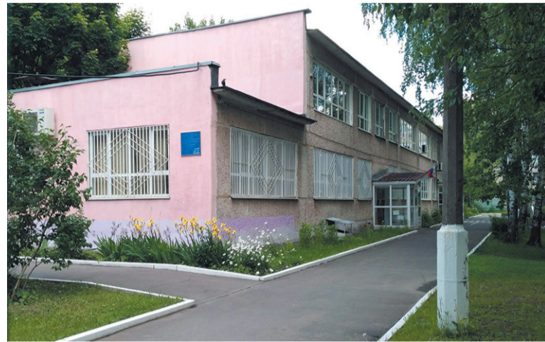
В здании «Солнышка» ещё ни разу не было капитального ремонта
